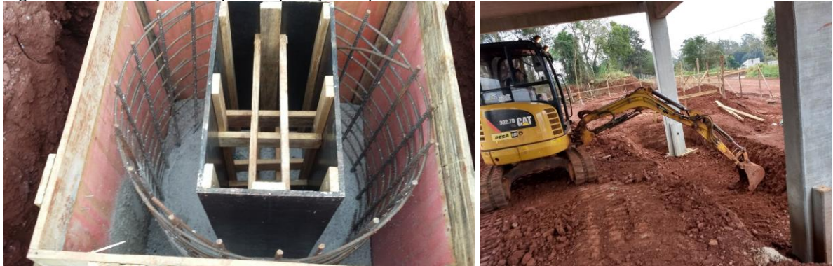
Figura 03 – Construção da sapata e aplicação de pilar.
