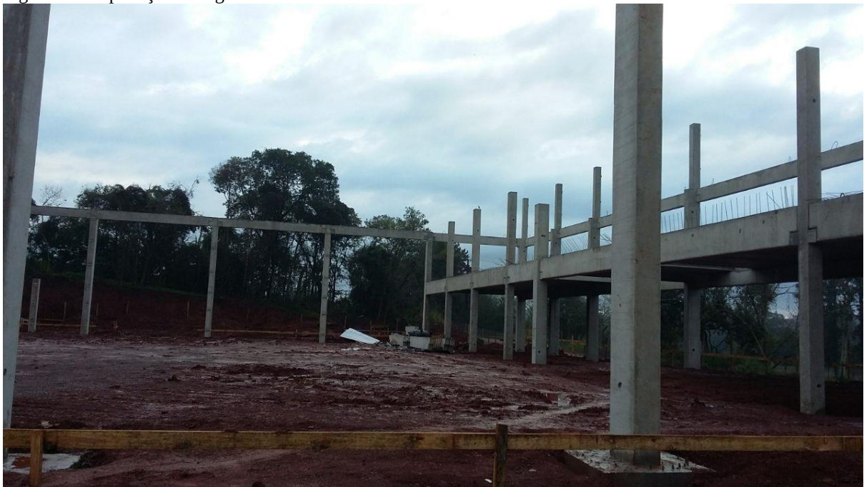
Figura 04 – Aplicação de vigas
