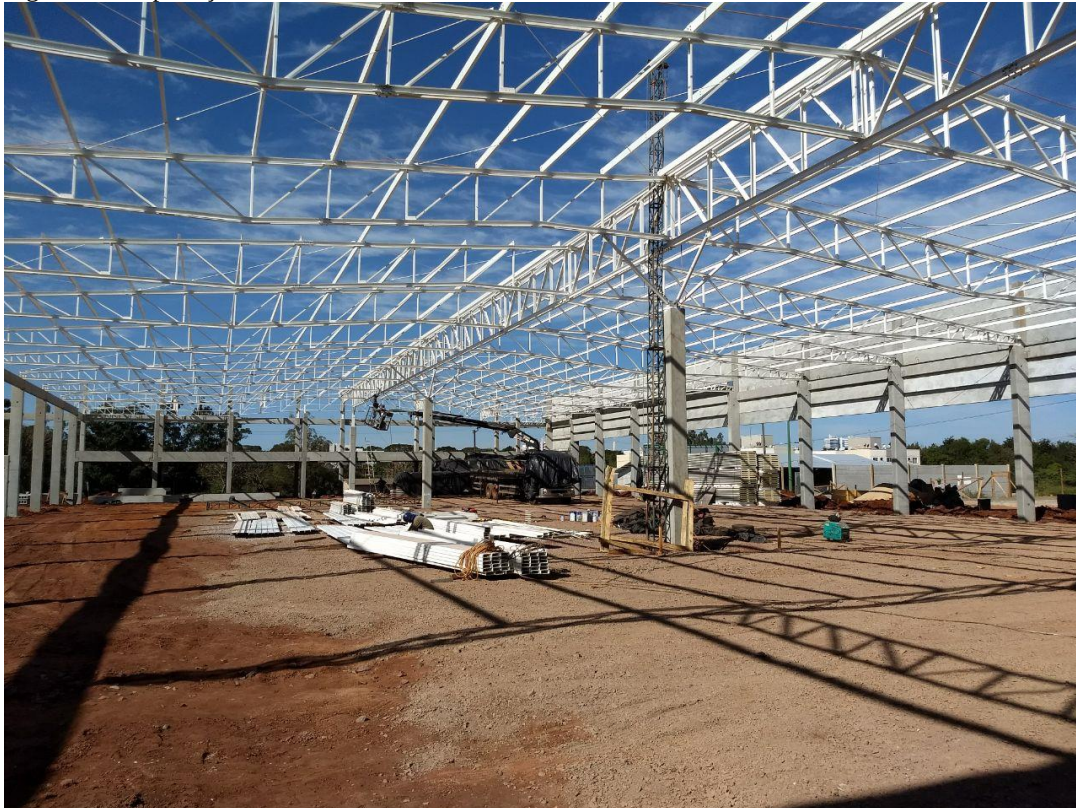
Figura 05 – Aplicação de estrutura metálica na cobertura
