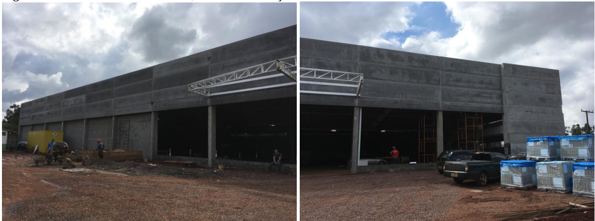
Figura 01 – Panorama Home Center, fase de construção.
