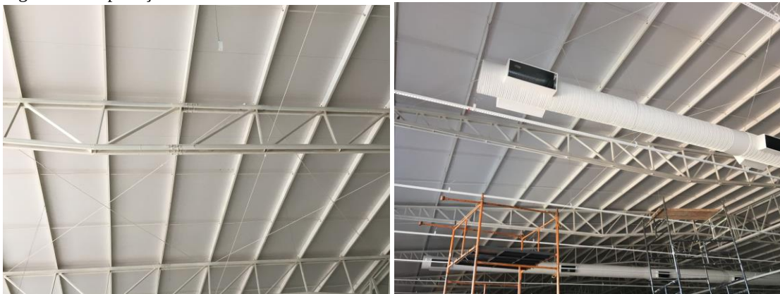
Figura 06 – Aplicação de vedamento cobertura
