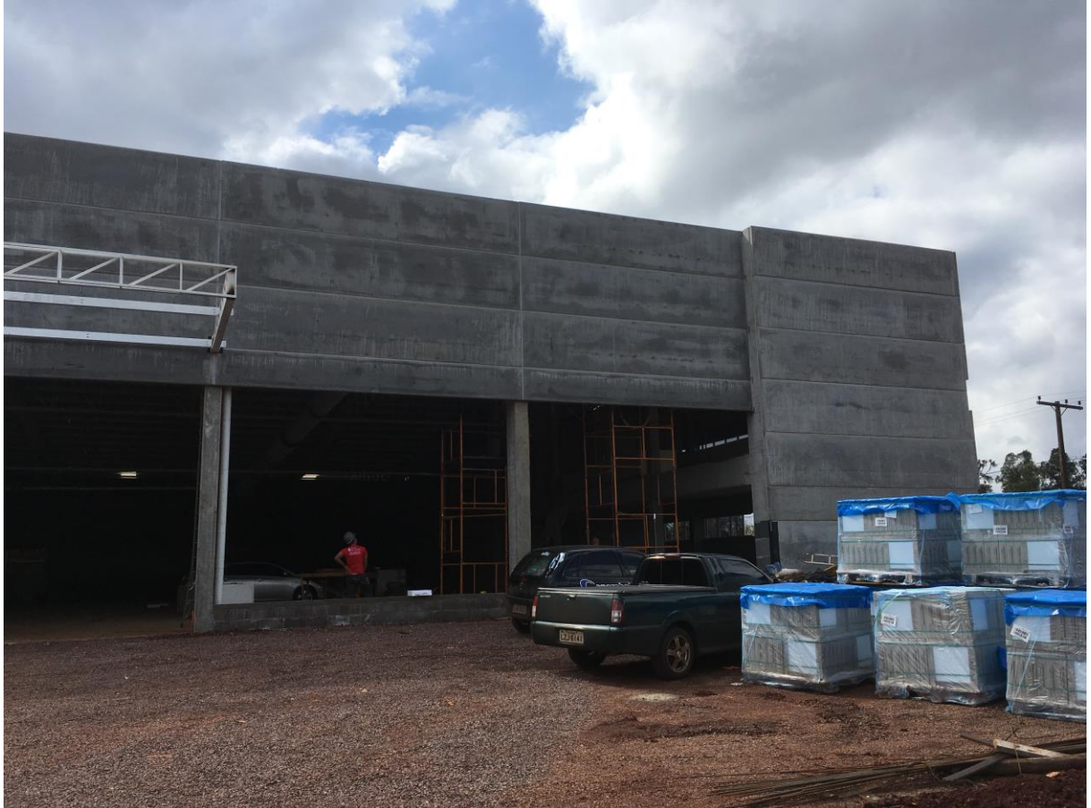
Figura 07 – Aplicação das placas cimentícias no vedamento da obra
