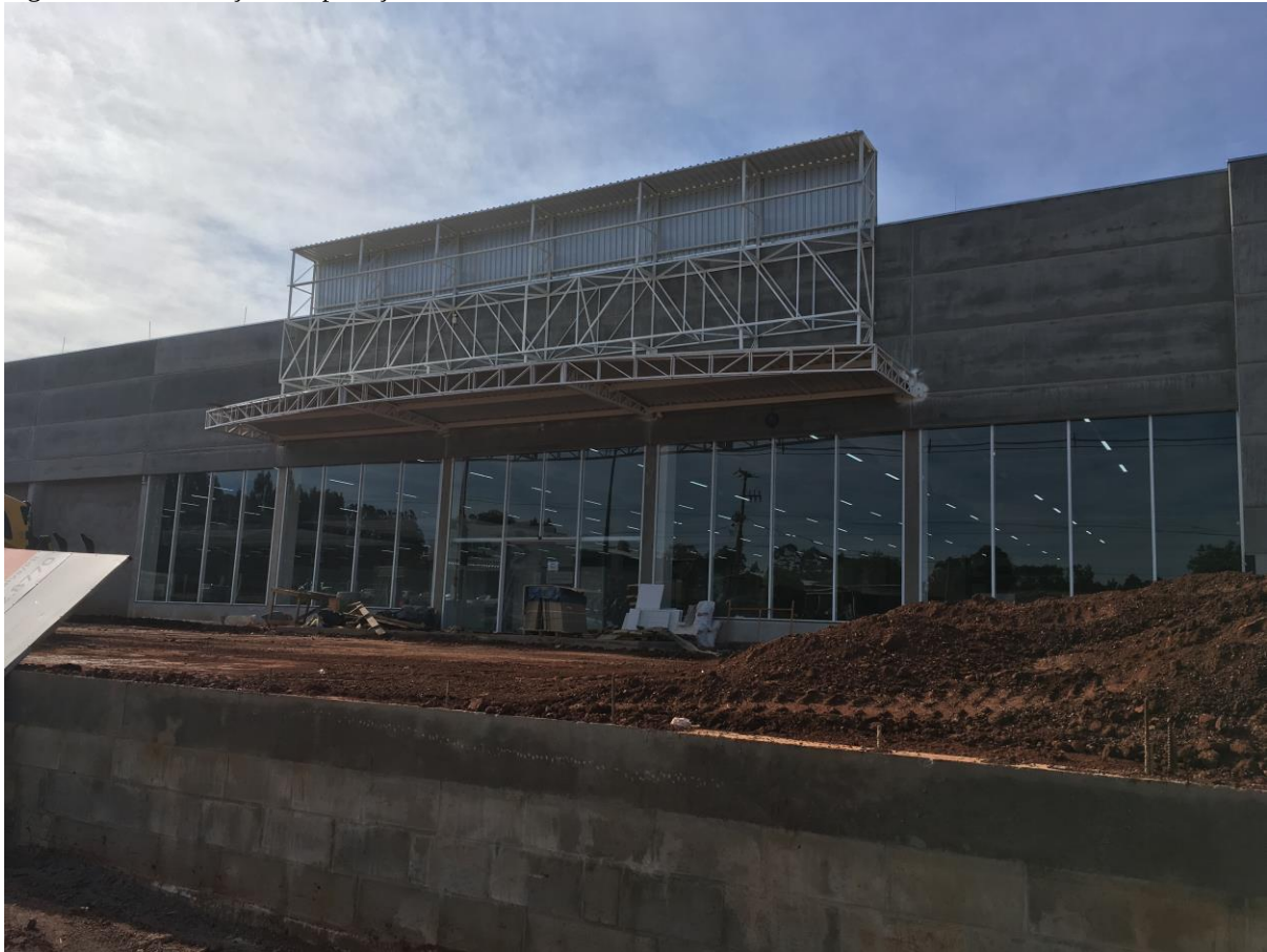
Figura 08 – Finalização da aplicação de vedamento com vidro.
