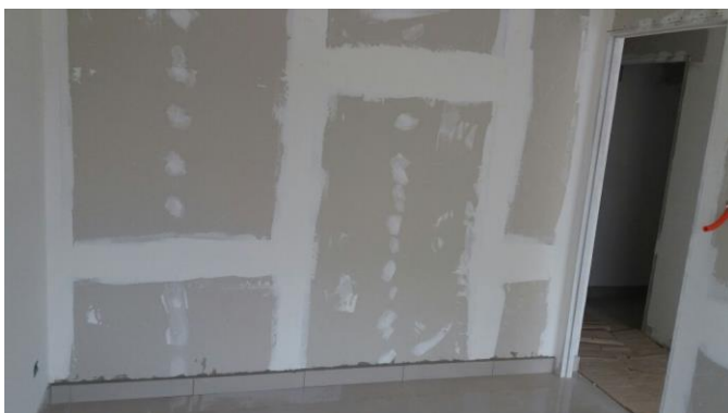
Figura 18 – Parede com aplicação de massa nas imperfeições
