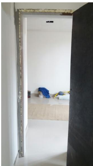
Figura 21 – Encaixe do marco da porta
