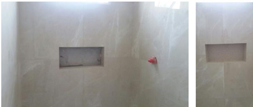
Figura 32 – Assentamento das pastilhas do banheiro
