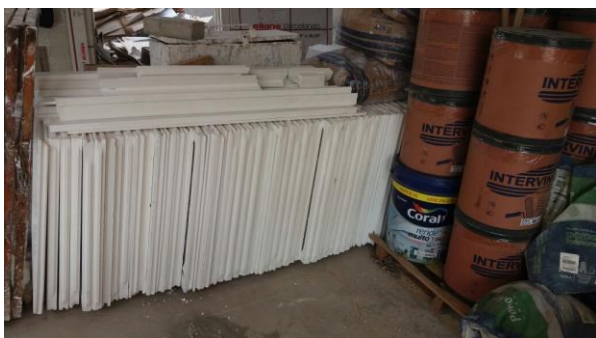
Figura 35 – Armazenamento de placas de gesso e de piso porcelanato
