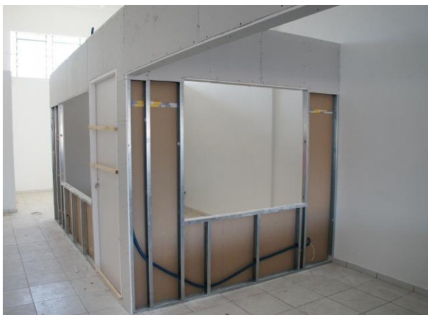
Figura 01 – Estrutura parede de gesso acartonado
