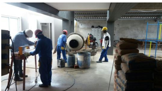
Figura 23 – Funcionários realizando a preparação da argamassa
