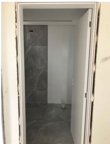
Figura 22 – Instalação das guarnições e das folhas das portas
