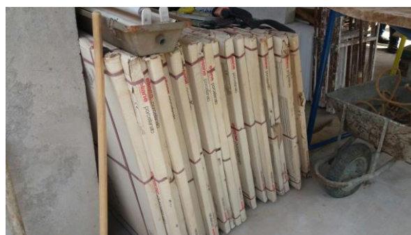
Figura 35 – Armazenamento de placas de gesso e de piso porcelanato
