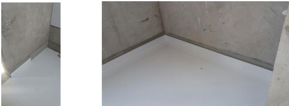
Figura 30 – Execução do rodapé na lavanderia
