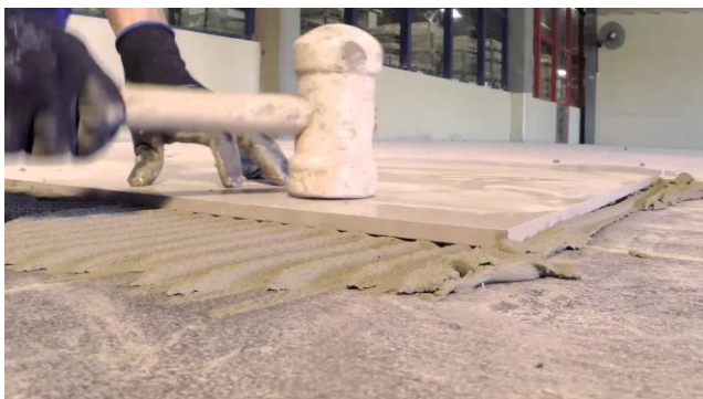
Figura 08 – Assentamento de piso com martelo de borracha
