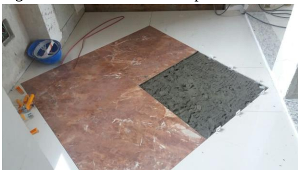
Figura 27 – Assentamento do piso no hall de entrada
