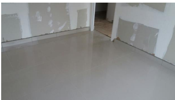
Figura 31 – Execução do rodapé nas paredes drywall
