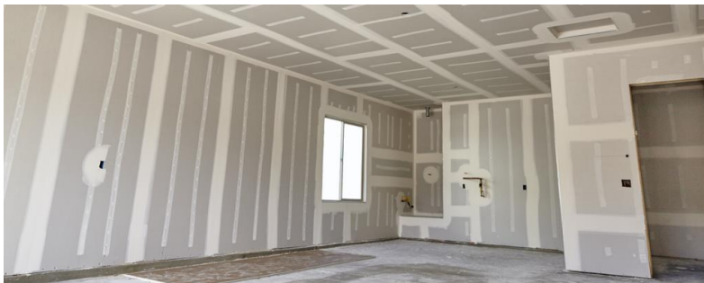
Figura 03 – Parede de drywall preparada para receber pintura
