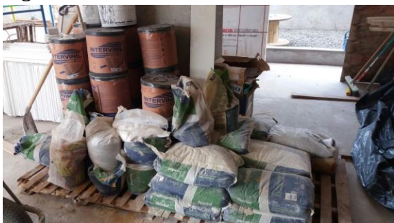
Figura 34 – Armazenamento de materiais ensacados
