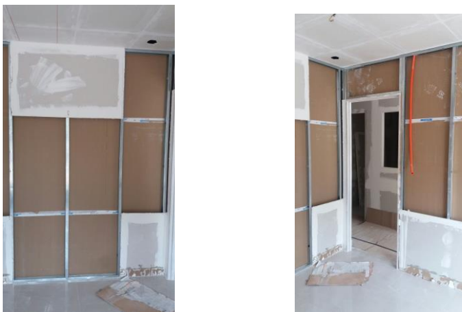
Figura 16 – Instalação do drywall
