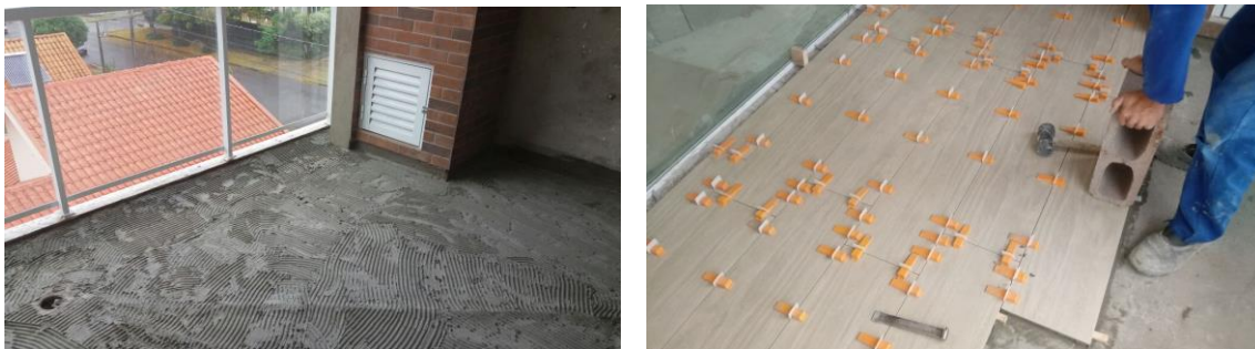
Figura 26 – Assentamento do piso na sacada
