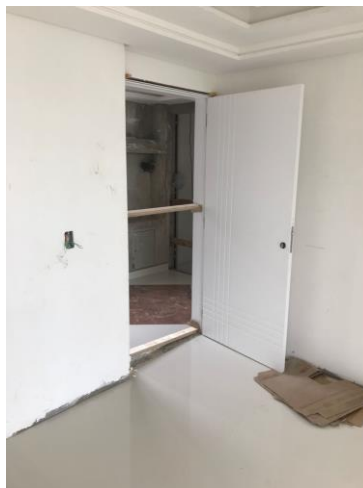
Figura 22 – Instalação das guarnições e das folhas das portas
