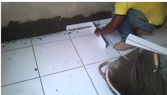
Figura 11 – Assentamento de rodapé cerâmico
