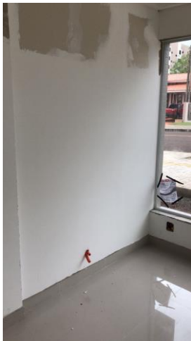
Figura 19 – Parede com aplicação de massa em toda sua superfície
