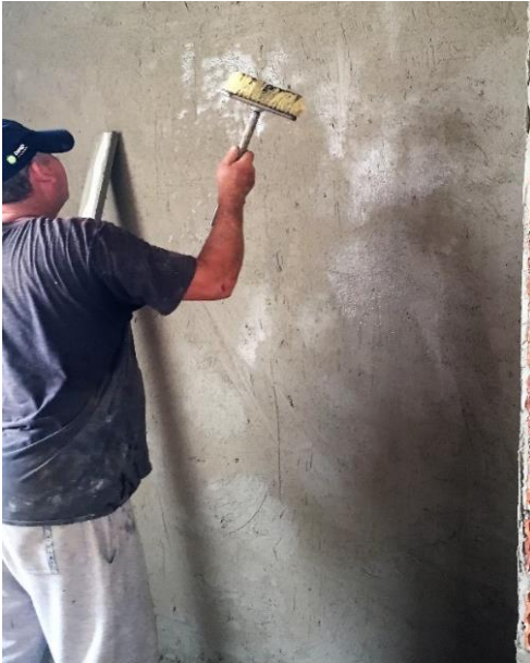
Figura 4 - Reboco: utilização do equipamento brocha.
