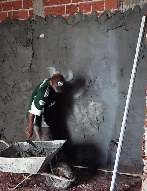
Figura 2 - Atividade de emboço sendo realizada.
