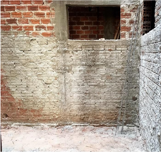
Figura 1 - Parede com chapisco.
