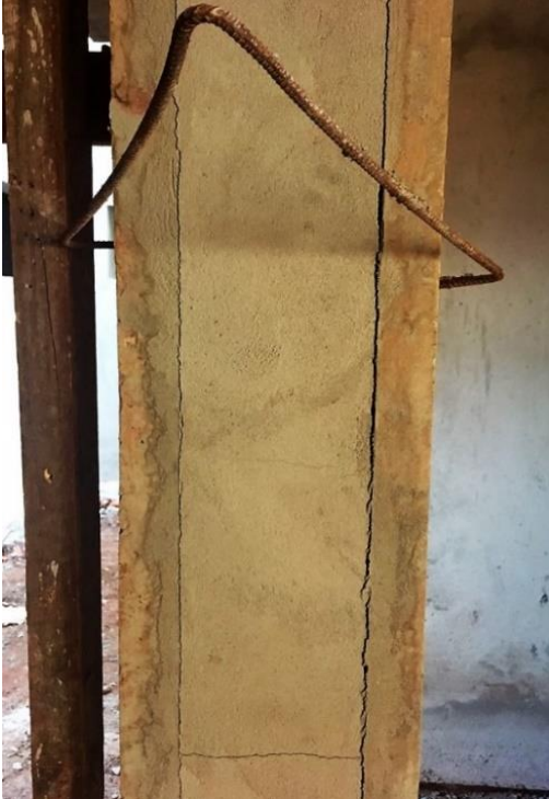
Figura 7 - Requadro de pilares.
