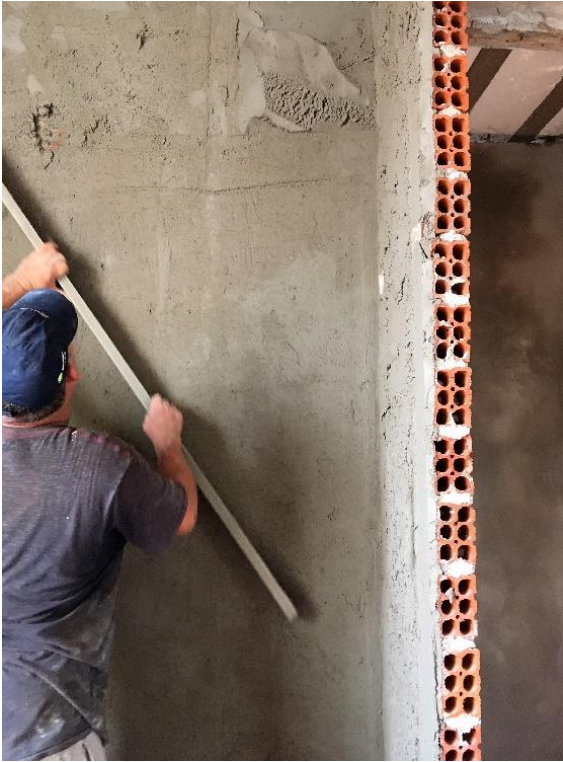
Figura 3 - Requadro de parede com uma régua de alumínio.
