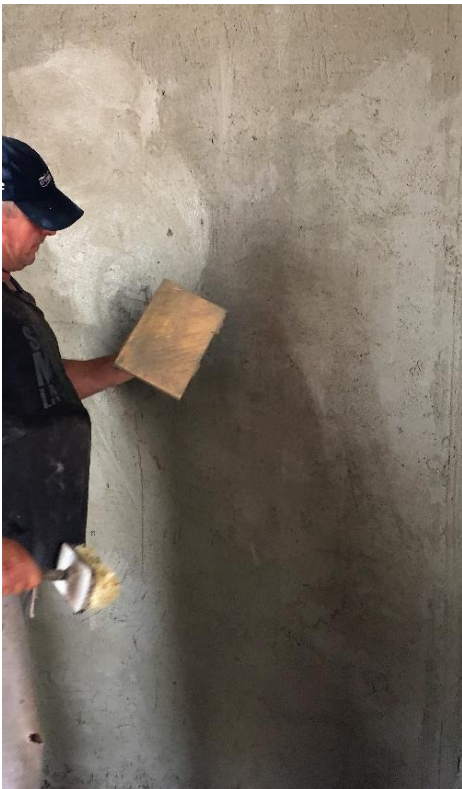
Figura 5 - Reboco: utilização do equipamento desempenadeira.
