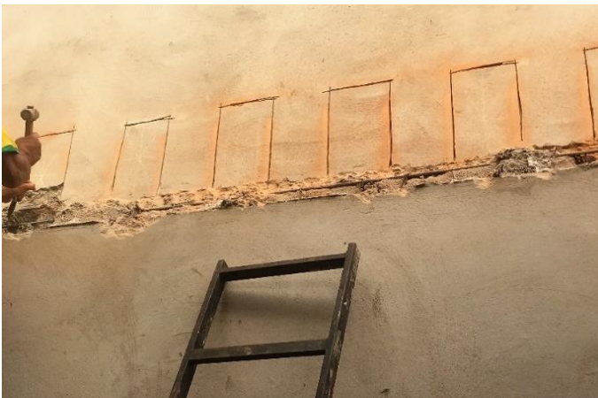
Figura 10 - Quebra de concreto com os equipamentos marreta e ponteiro.
