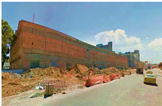
Figura 3 – Armazém 4 do Cais do Porto.
