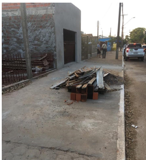
Figura 09: Calçada sendo usada irregularmente.
