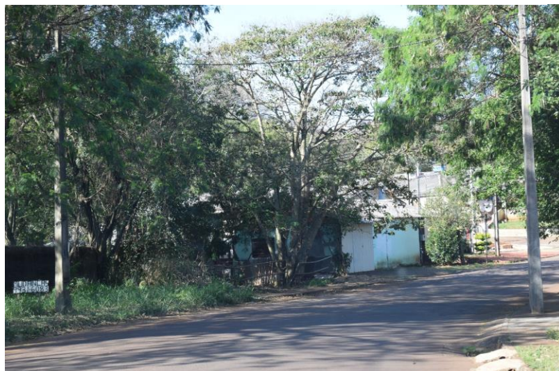
Figura 9 – Casa com ocupação irregular em fundo de vale e APP
