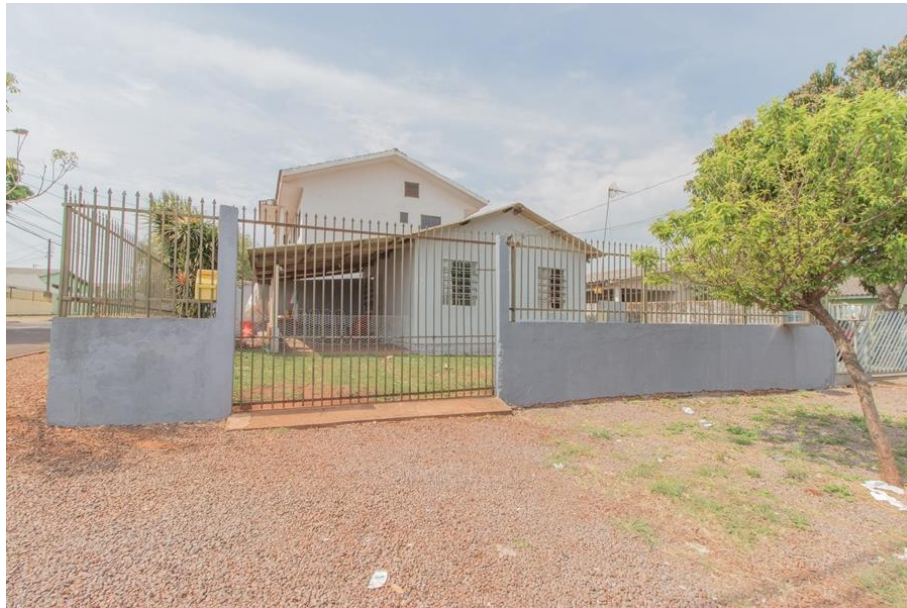
Figura 15 – Ausência de superfície uniforme
