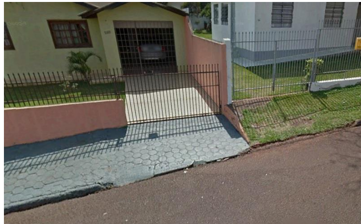
Figura 19 – Inclinação irregular e barreira
