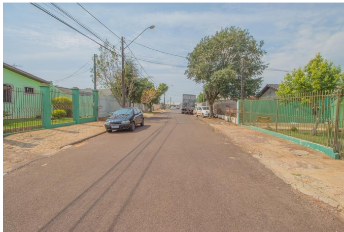
Figura 21 – Ausência da faixa de serviços
