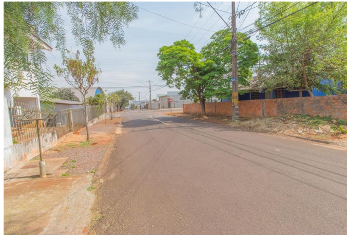
Figura 17 – Ausência de superfície uniforme e barreiras
