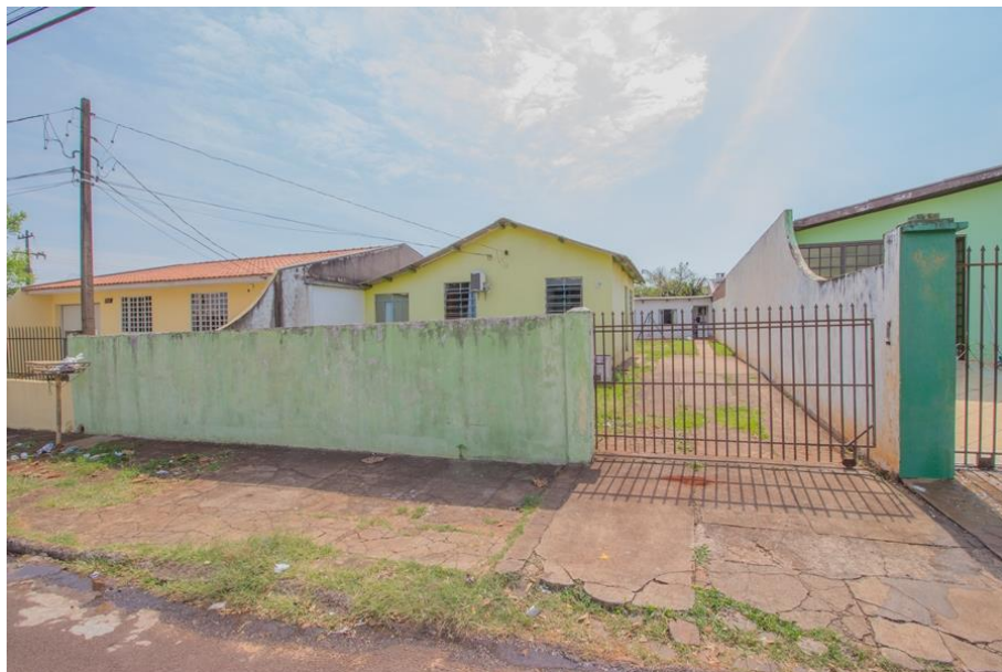
Figura 16 – Ausência de superfície uniforme
