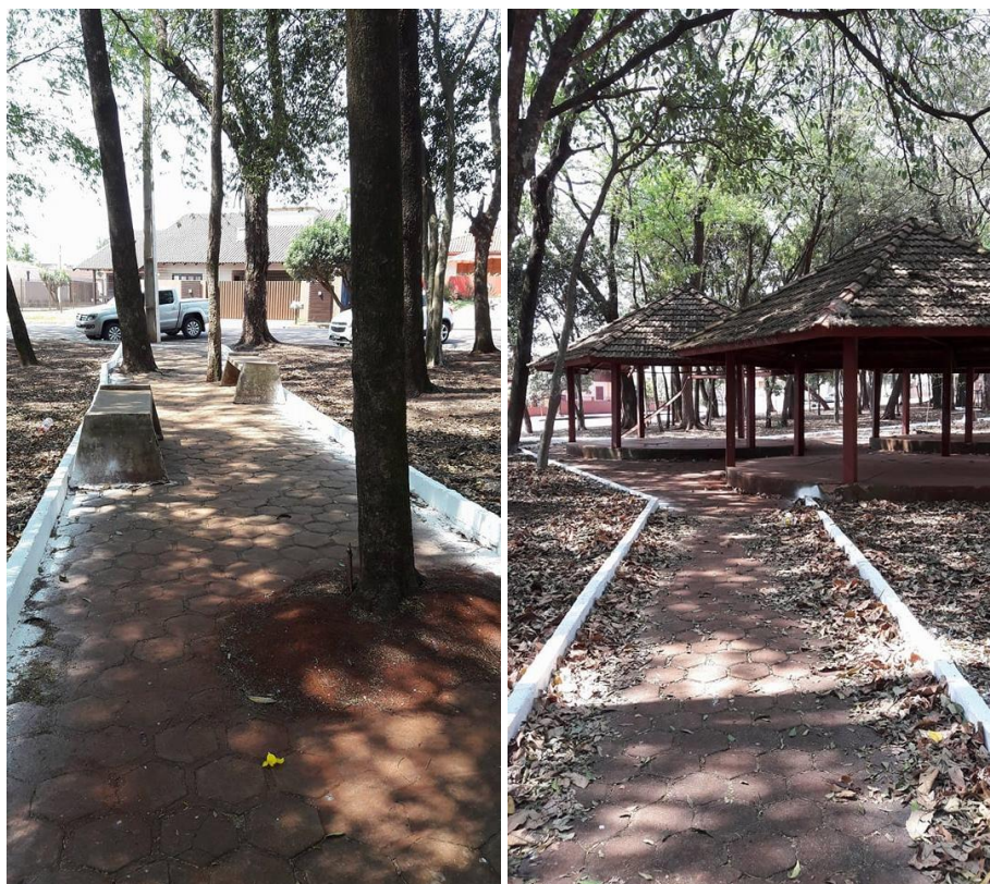
Figura 8 - Passeio sem acessibilidade
