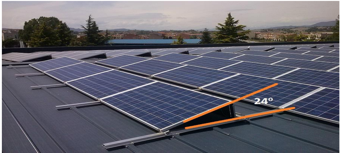
Figura 19: fixação dos painéis fotovoltaicos
