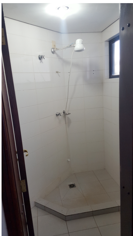
Figura 10: Banheiro antes da demolição e desativação
