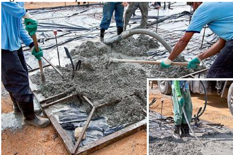
Figura 01 – Execução de radier
