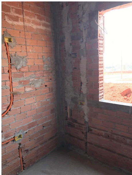
Figura 3 – Encamento do gás na parede
