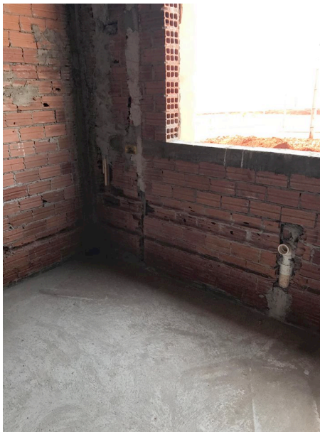
Figura 4 – Encamento da água e esgoto sendo passado
