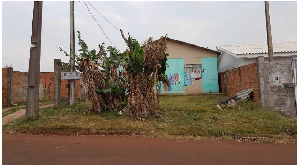
Figura 13 – Fachada frontal atual da edificação
