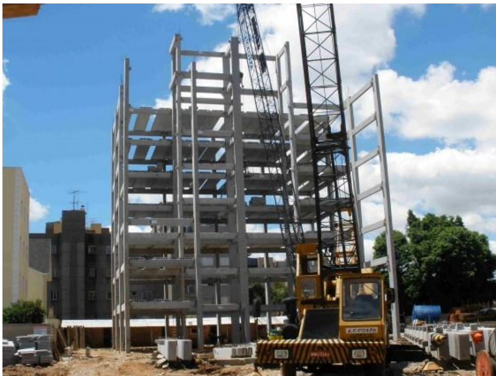
Figura 3 - Exemplo de construção pré-fabricada
