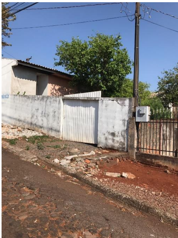
Figura 12 – Calçada Degradada.
