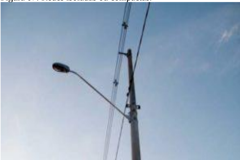
Figura 07: Redes isoladas ou compactas.
