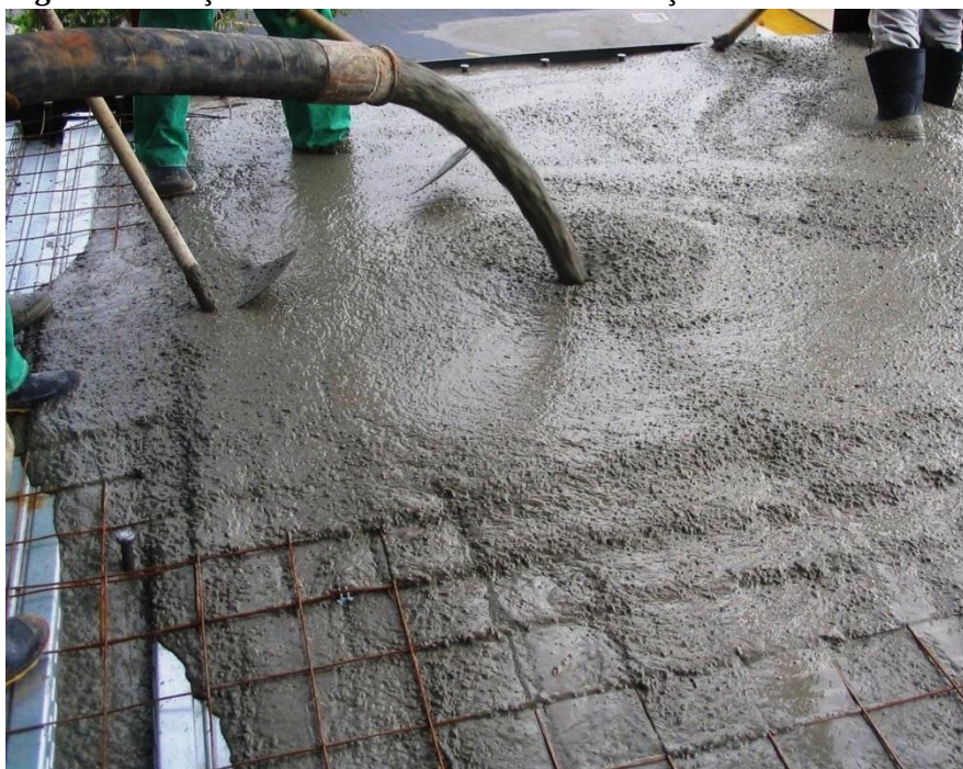
Figura 4 - Lançamento do concreto e com a utilização de armaduras
