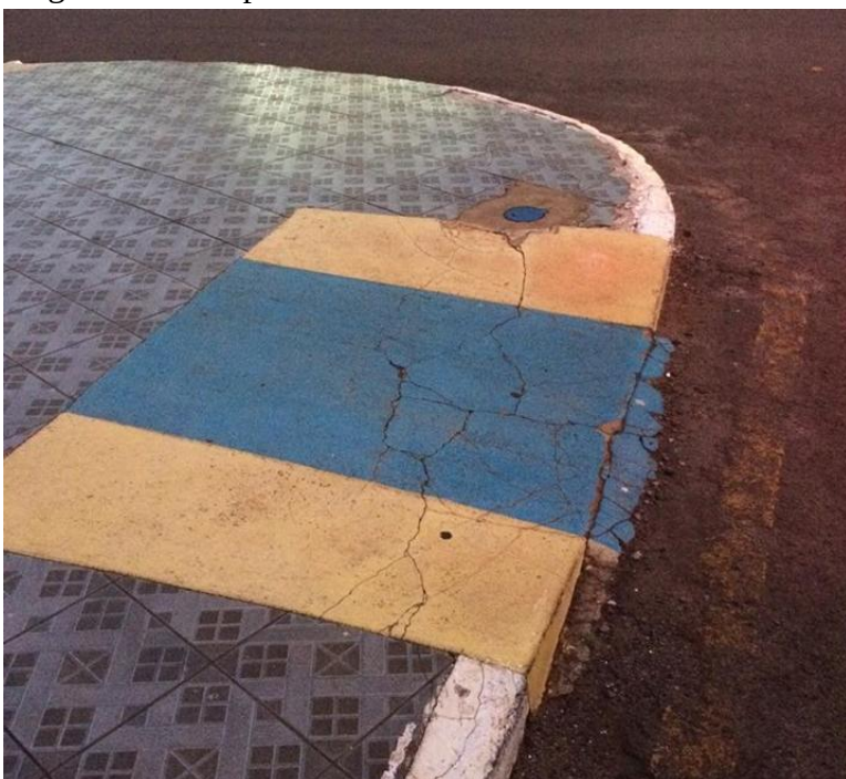
Figura 10- Rampa de acesso
