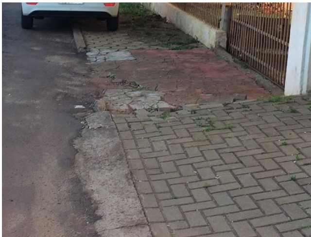
Figura 8- Revestimento do piso
