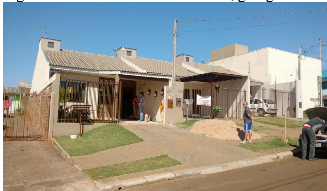
Figura 02 – Unidade residencial 01, garagem
