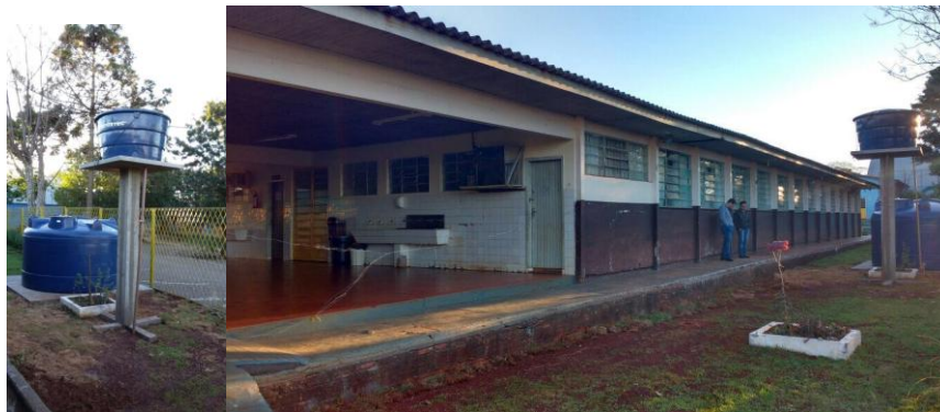
Figura 1 – Reservatório e Cobertura receptora da água da chuva.
