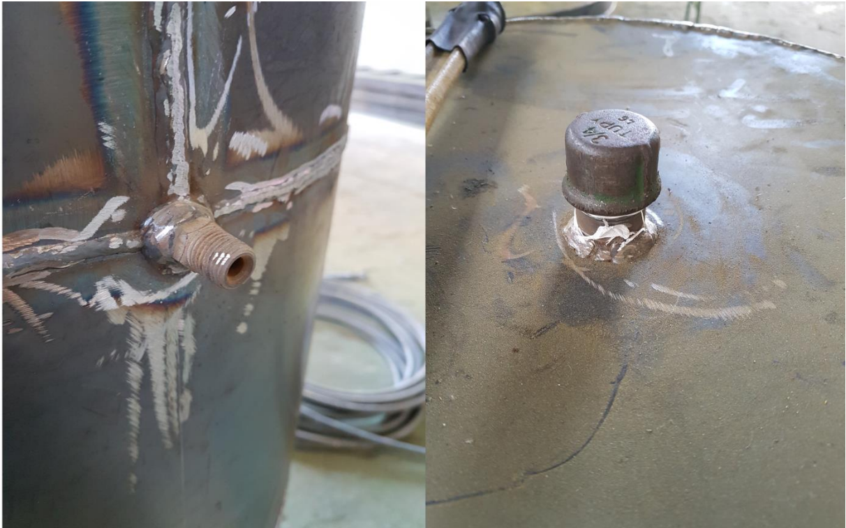
Figura 20 - Conexões hidráulicas utilizadas para ensaio hidrostático
