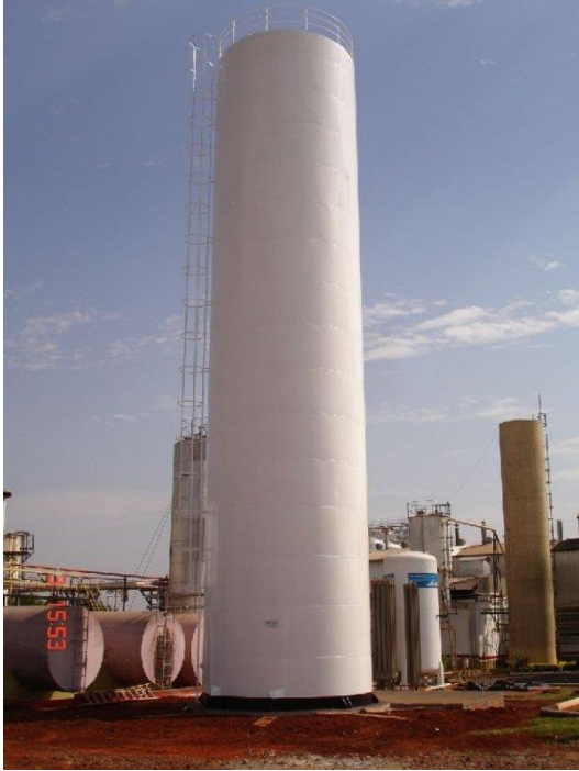
Figura 01 - Reservatório metálico vertical cilíndrico
