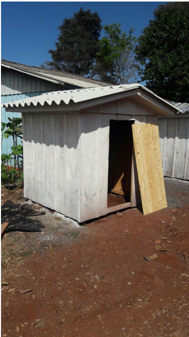
Figura 13 – Cobertura em telha de fibrocimento
