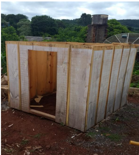
Figura 8 - Levantamento das paredes
