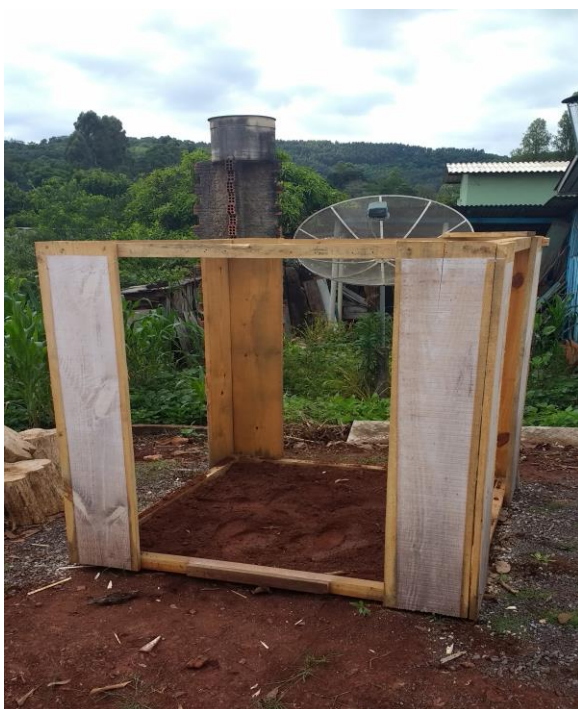
Figura 7 - Levantamento dos pilares
