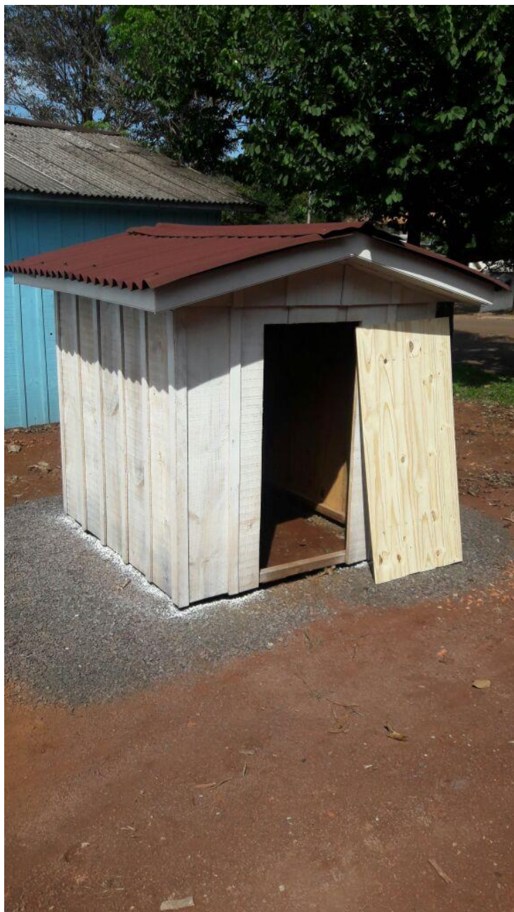
Figura 12 – Cobertura com telha de papel reciclado
