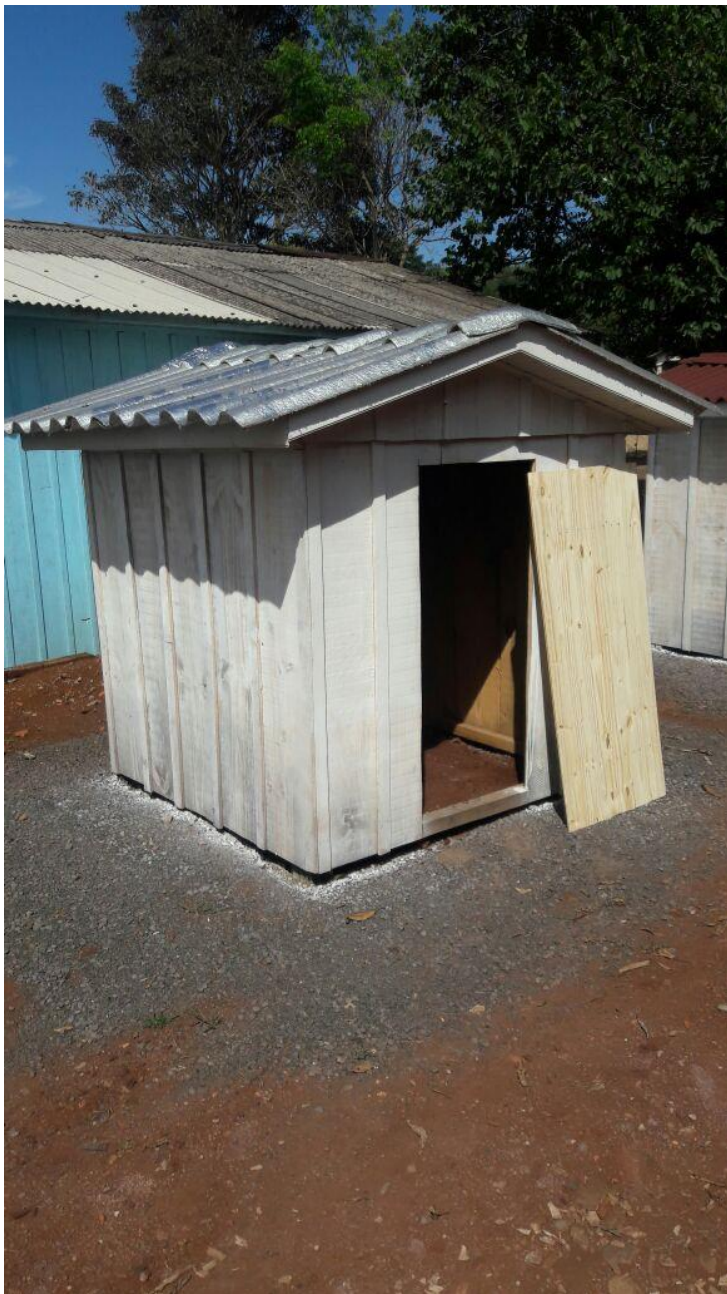
Figura 11 – Cobertura com telha de embalagens longa vida
