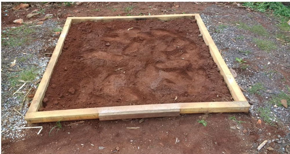
Figura 6 – Base para construção dos protótipos
