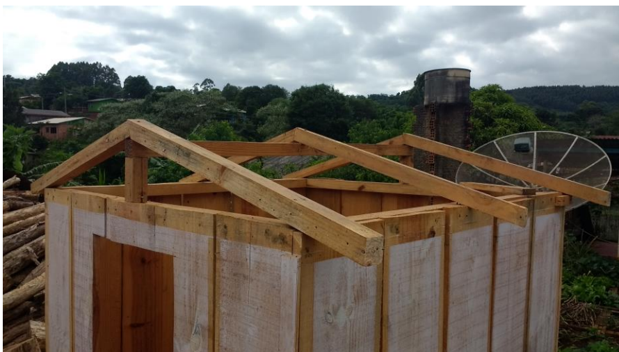
Figura 10 – Estrutura da cobertura
