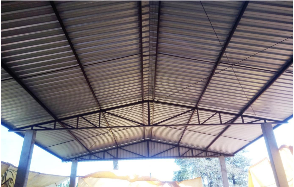
Figura 8 - Galpão metálico
