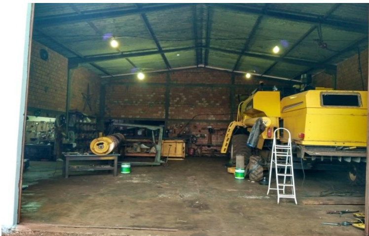
Figura 7 – Local de Implantação do Pórtico Rolante
