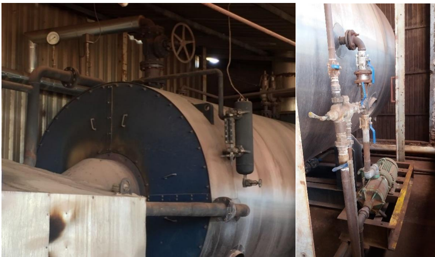
Figura 12: Dispositivos de segurança da caldeira 2.
