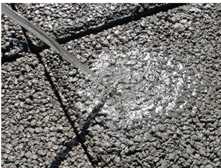
Figura 5 – Paver de concreto poroso.
