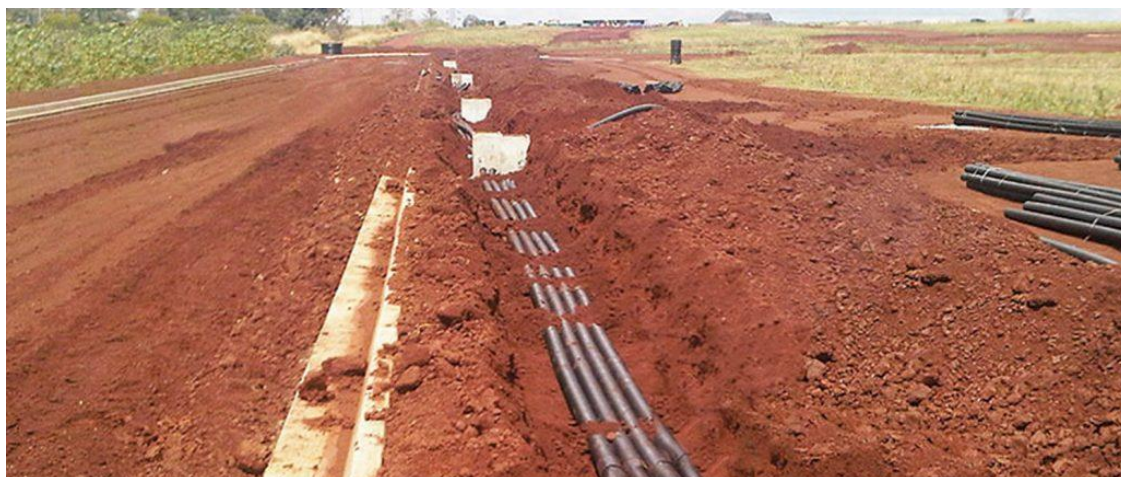
Figura 2 – Instalação de rede subterrânea.
