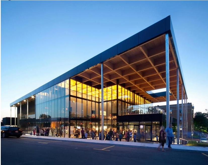
Figura 20 – Cobertura do edifício.
