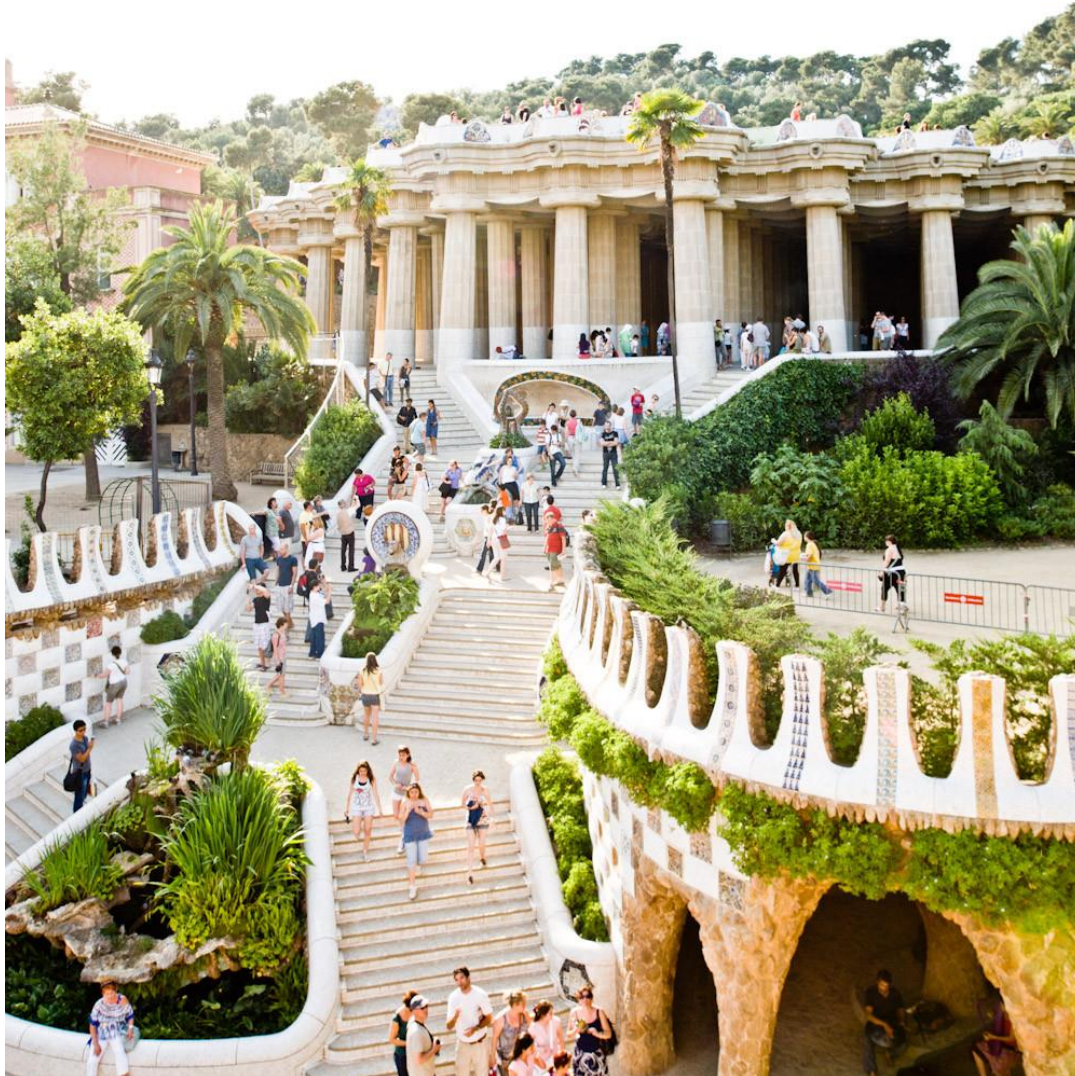
Figura 18: Escadarias e terraços do Parque Guell.
