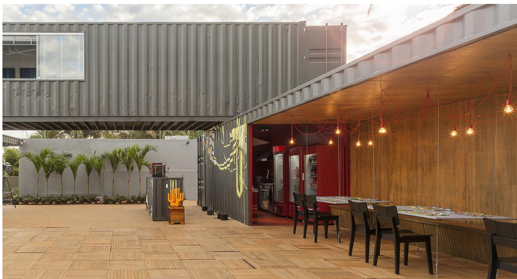
Figura 16: Revestimentos e iluminação.
