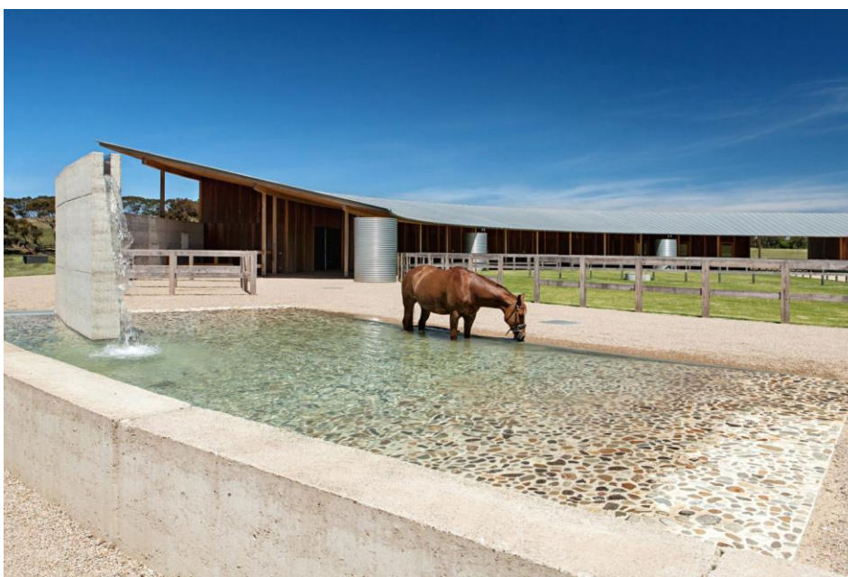
Figura 17: Vista lateral interna do centro.
