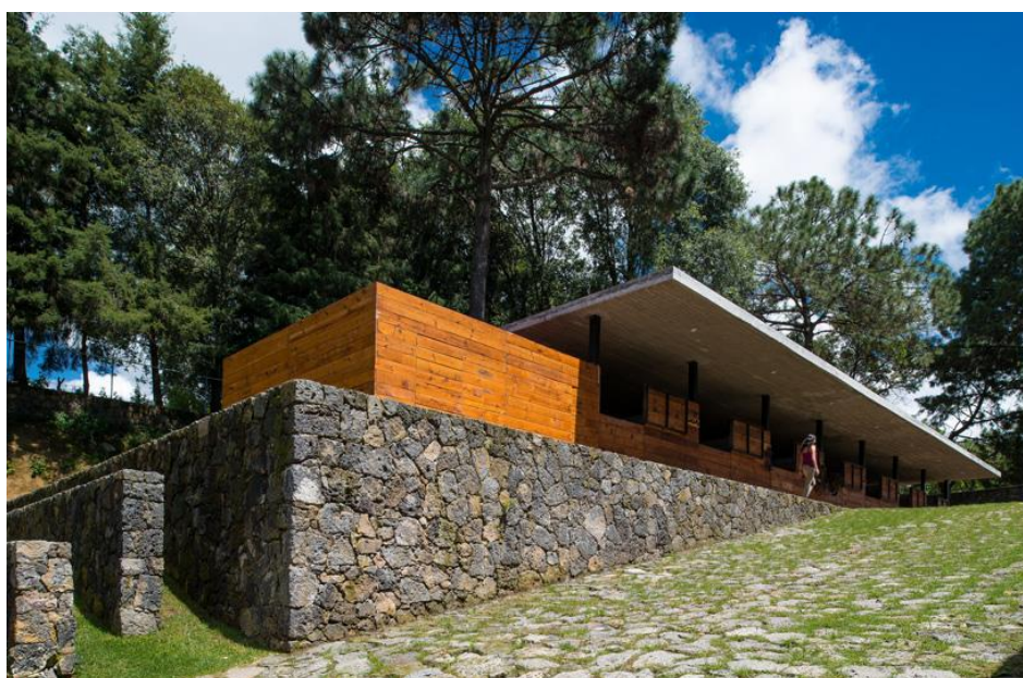
Figura 21: Imagem externa do Centro.
