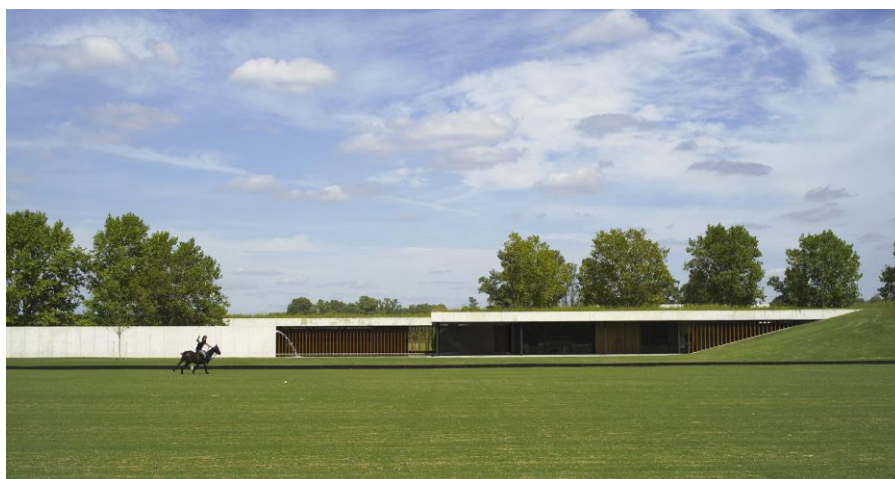
Figura 27: Horizontalidade do edifício.
