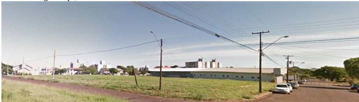
Figura 21 - Imagem externa do terreno de implantação
