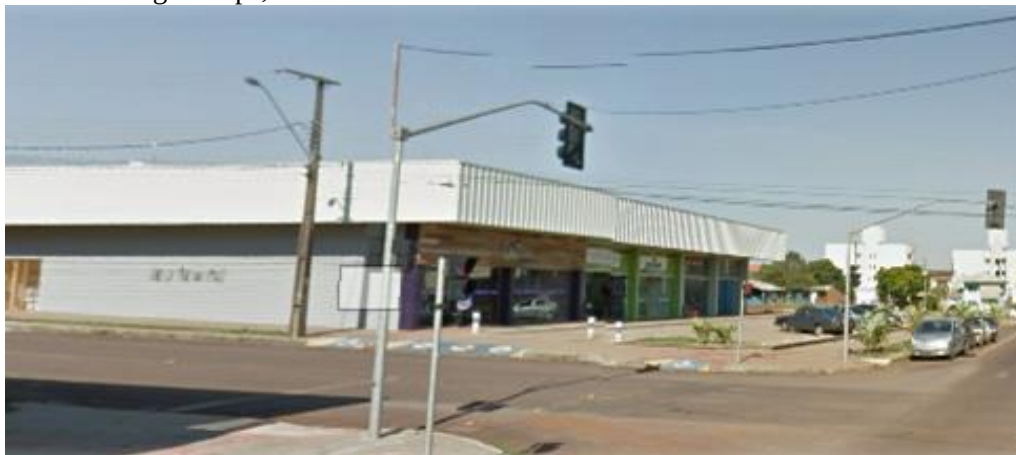
Figura 22 - Imagem externa do terreno de implantação
