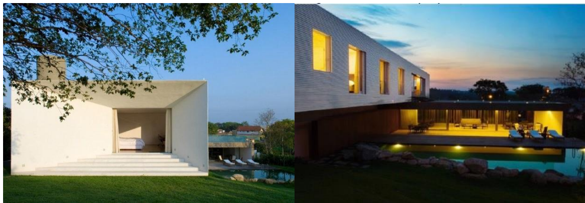
Figura 14: Blocos perpendiculares e Fachada norte da Casa Piracicaba
