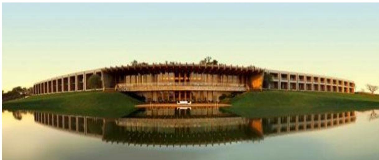
Figura 01: Fachada Panorâmica Fasano Hotel Boa Vista
