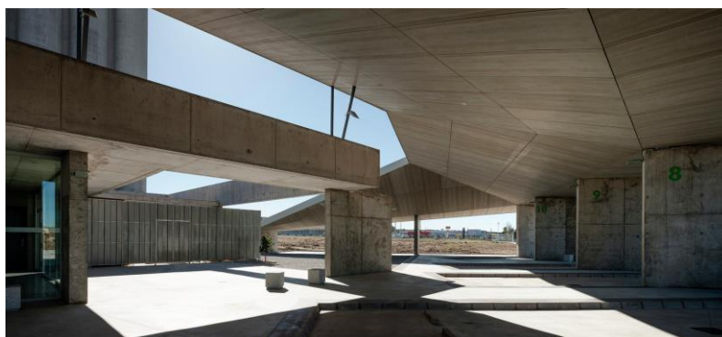
Figura 4: Uso de concreto na estação de ônibus em Trujillo
