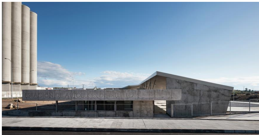
Figura 1: Estação de ônibus em Trujillo
