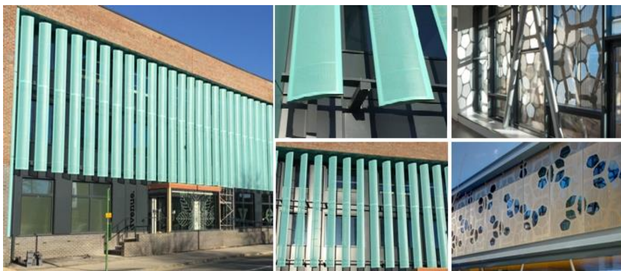
Figura 5 - Detalhe do sistema de controle solar tipo brise do Eastleigh College (à esquerda os brises verdes na vertical, e na direita, os painéis perfurados na cor dourada).
