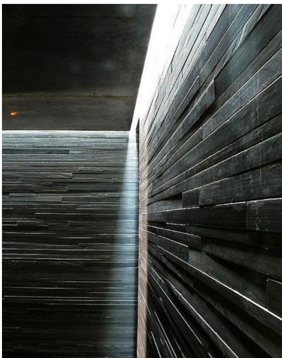
Figura 12 - Entrada de luz através do afastamento entre os blocos
