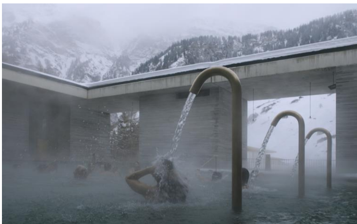
Figura 14 - Bicas de Água Aquecida da Piscina Externa
