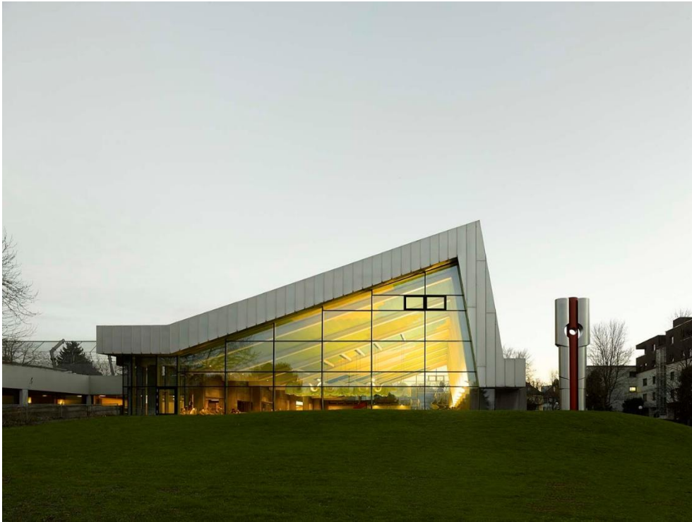
Figura 8: Fachada do Centro Esportivo em Leonberg reformada
