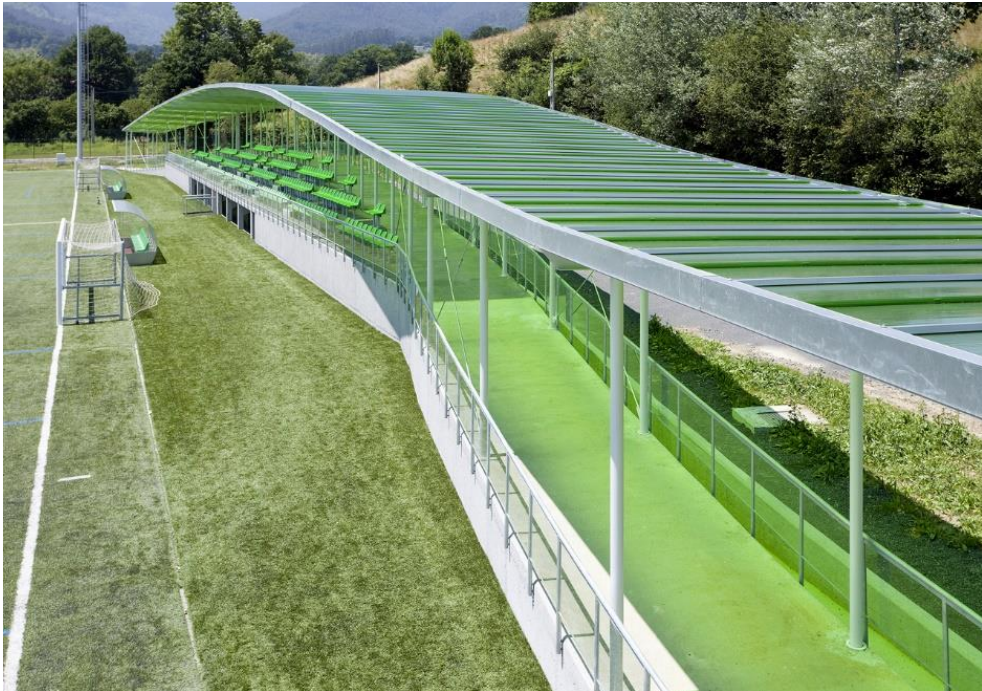
Figura 3: Cobertura que abriga a arquibancada e o passeio do campo Sopenuerta
