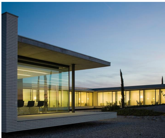
Figura 7 – Pavilhão de Construção Técnica do Hospital Geral Universitário de Toledo / TASH
