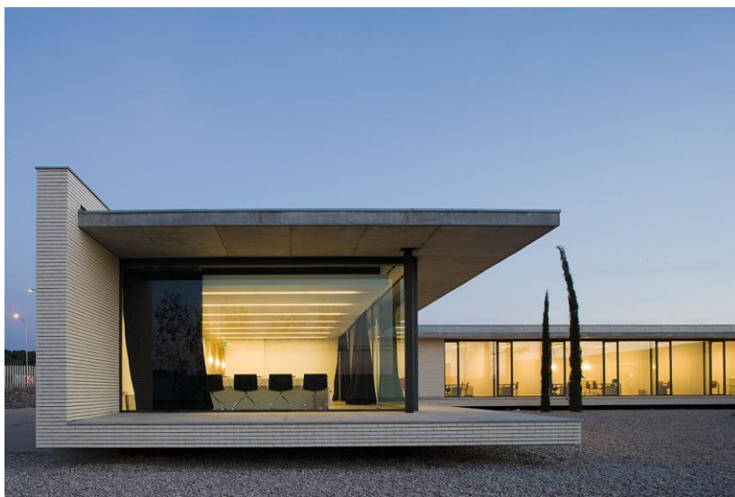
Figura 6 – Pavilhão de Construção Técnica do Hospital Geral Universitário de Toledo / TASH
