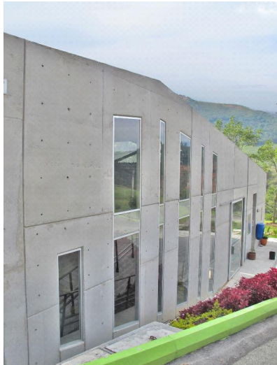
Figura 18- Fachada em concreto aparente
