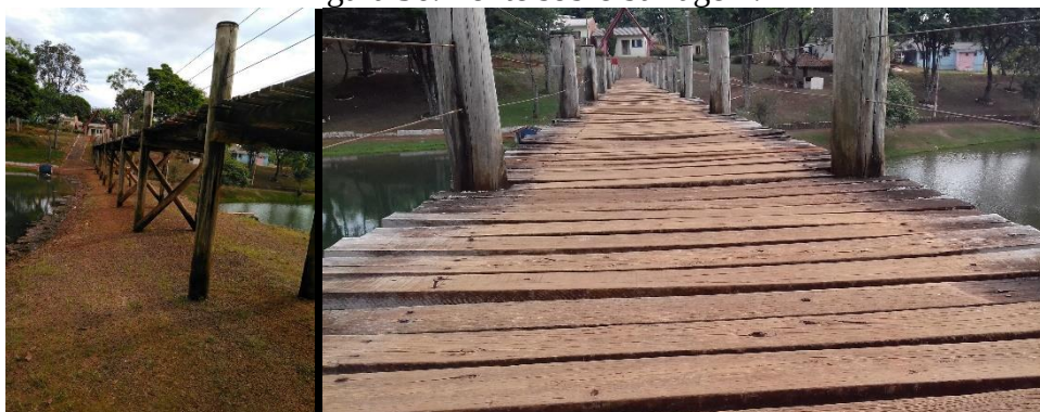
Figura 36: Ponte sobre barragem.
