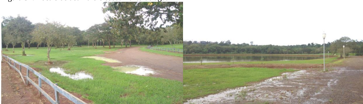
Figura 37: Locais de acumulo e escoamento de água
