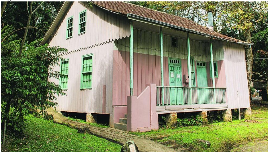
Figura 15: Casa Erbo Stenzel, antes do incêndio
