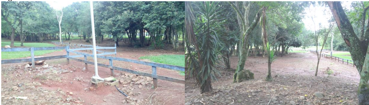
Figura 38: Início de erosão - área sem cobertura
