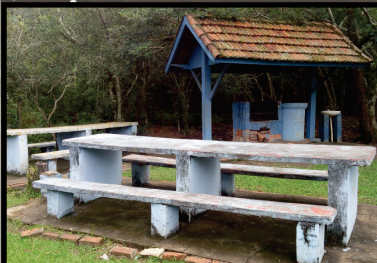
Quiosque e mesa deteriorado
