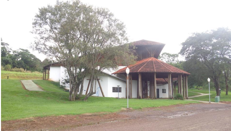
Figura 28: Centro Ambiental Dionísio Binatti
