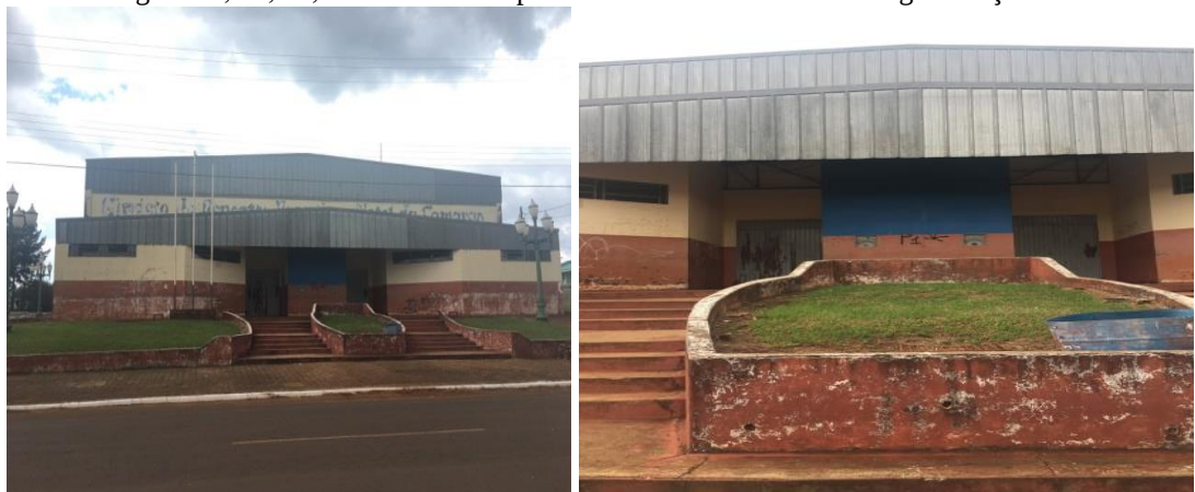
Figura 20, 21, 22, 23: Centro de esportes Francisco Natel de Camargo situação atual.
