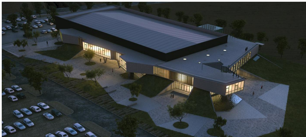
FIGURA 13: Conexão com o solo através de rampas verdes
