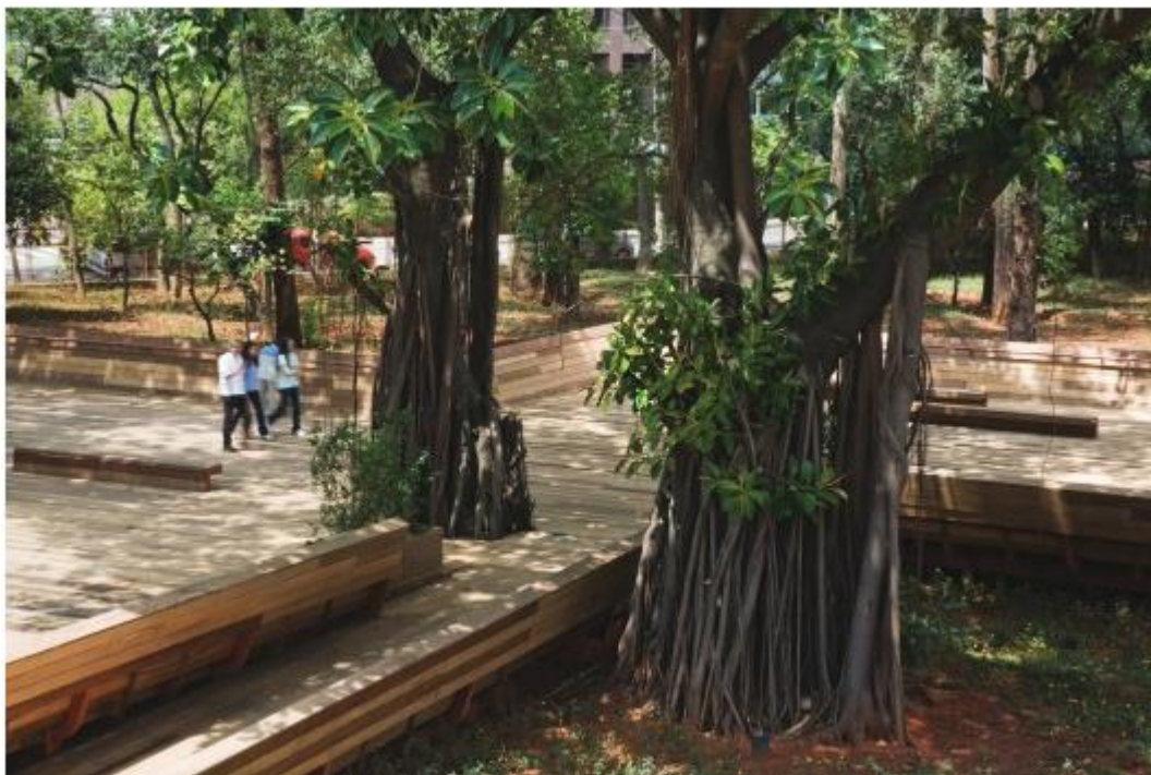
FIGURA 16: Deck suspenso para evitar o contato com o solo contaminado
