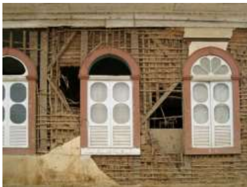
Figura 03: Parede de Pau – a – Pique em São Luiz do Paraitinga, SP.
