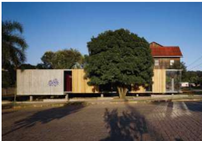
Figura 14: Vista lateral do museu e seu anexo.
