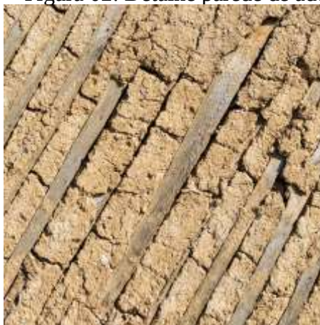
Figura 02: Detalhe parede de adobe
