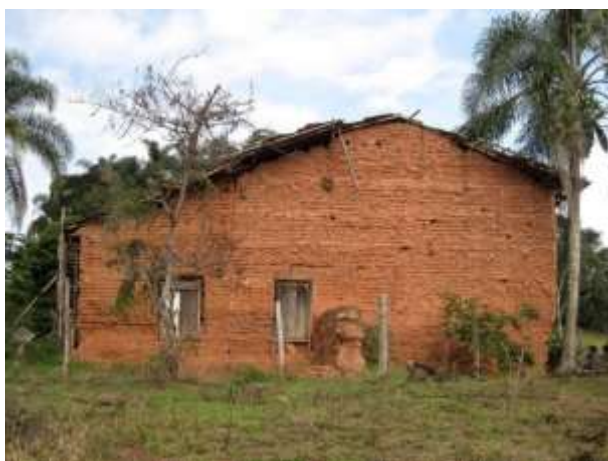
Figura 01: Parede de Taipa de pilão no Sítio Solidão, Guararema SP.
