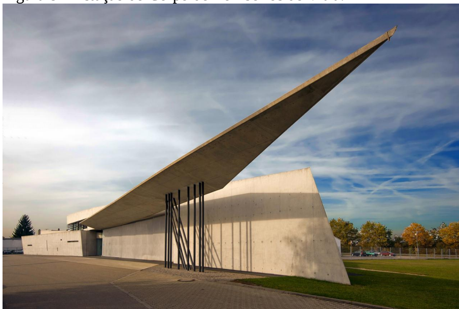
Figura 8 – Estação do Corpo de Bombeiros de Vitra:
