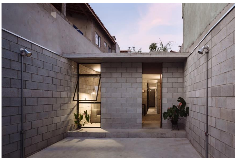
Figura 20: Vista pátio de entrada/estacionamento, Casa Vila Matilde.
