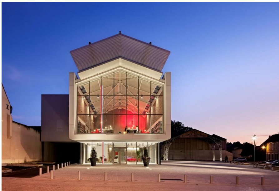
Figura 14: Vista da fachada principal.
