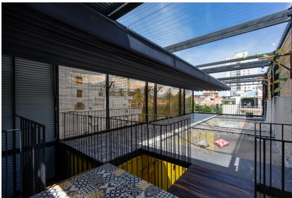
Figura 7: Redes suspensas na cobertura.
