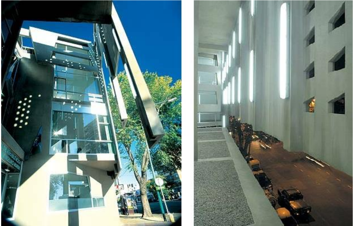
Figura 24 e 25. Vista do Brise em concreto armado e perfurações que parecem janelas.
