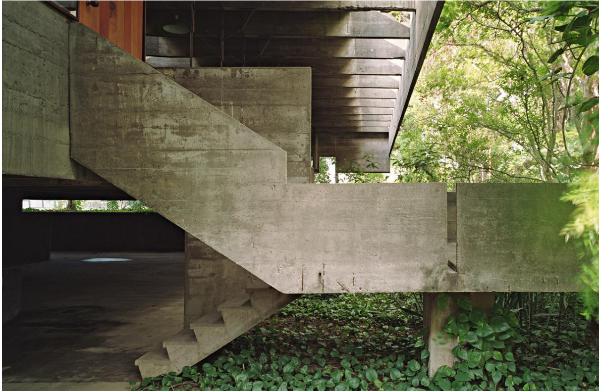
Figura 03. Exemplo de concreto armado.
