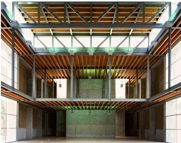
Figura 28 e 29. Vista da estrutura em concreto armado, aço e vidro.
