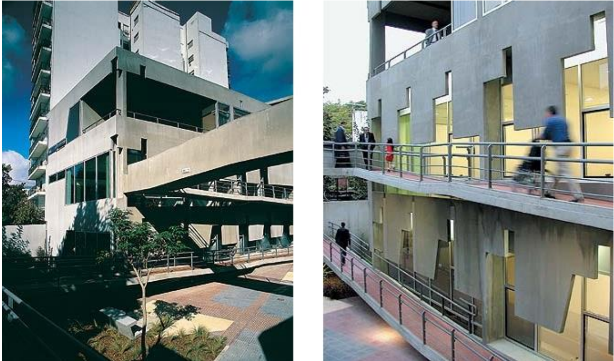
Figura 22 e 23. Vista da estrutura em concreto armado.
