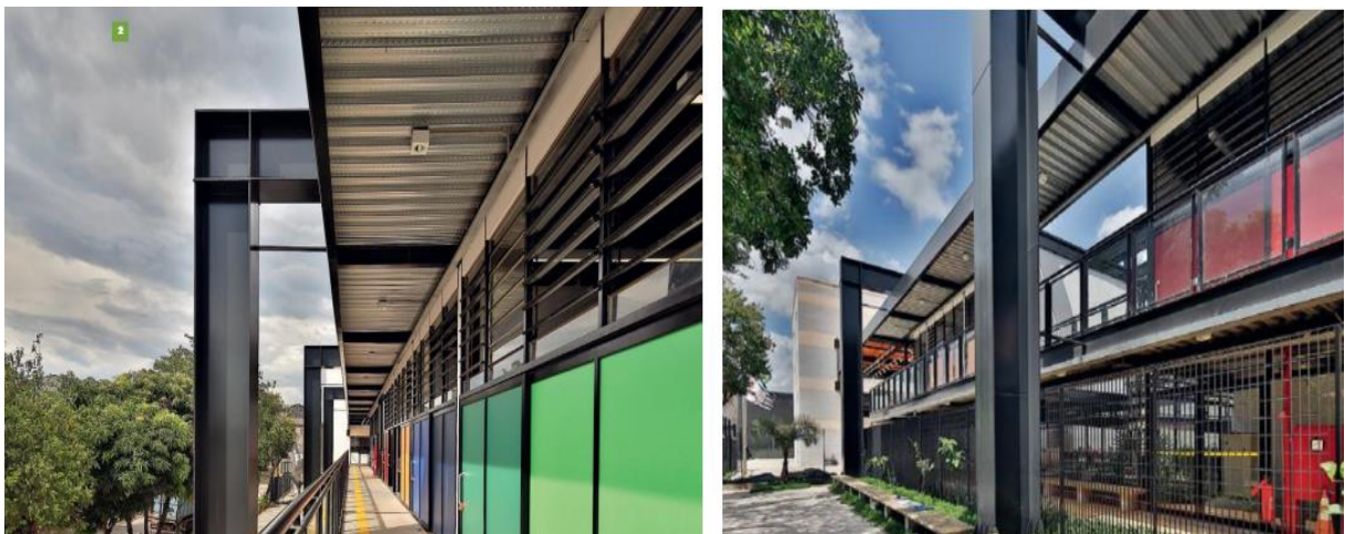
Figura 09 e 10. Vista do corredor lateral e os elementos metálicos.
