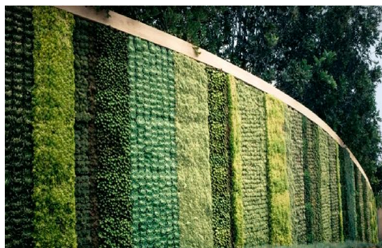
Figura 4: Parede Verde externa
