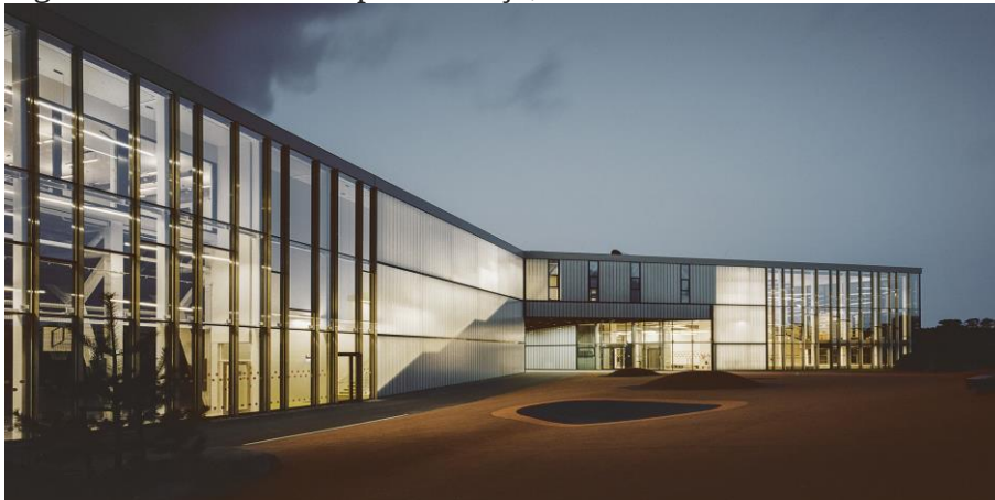
Figura 05 - Fachada composta de aço, vidro e alumínio
