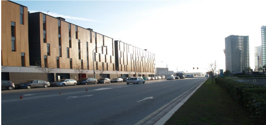
Figura 13 - Fachada norte voltada para a rua comercial
