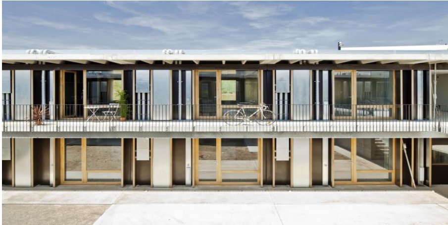
Figura 20 – Varanda de circulação
