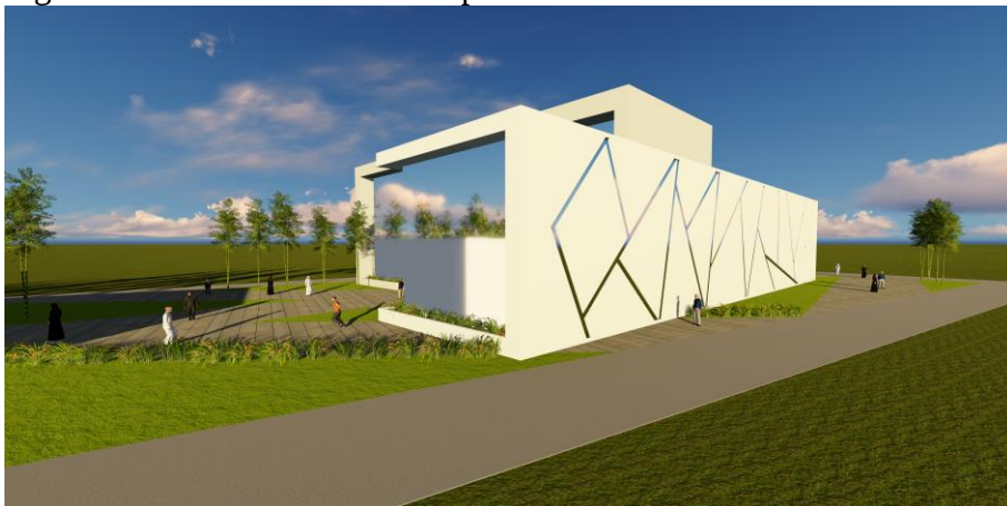
Figura 34 – Painéis em Acm dispostos nas fachadas
