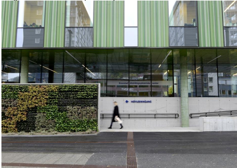
Imagem 3 - Lateral do Hospital, via pública
