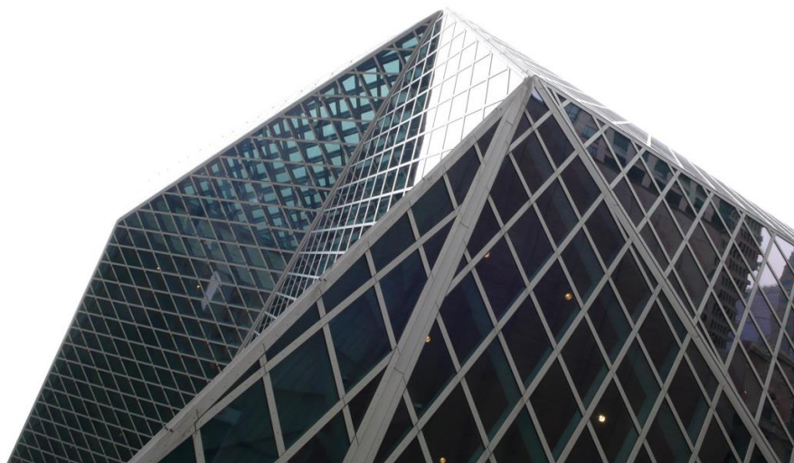
Figura 24 – Estrutura de aço e vidro.
