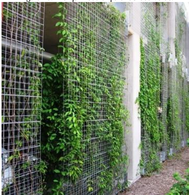
Figura 10: Treliça Modular para fachada verde.
